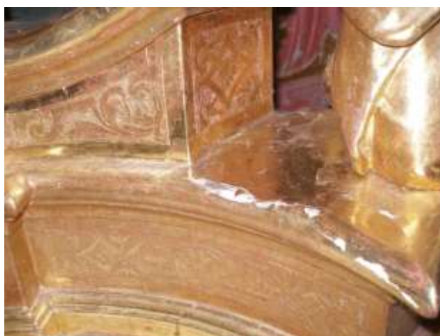
Slika 25. Detalj pozlate glavnog oltara desetak godina nakon konzervatorsko-restauratorskih radova, župna crkva Marije Snježne u Belcu (XVIII. st.) – propadljivost zlata kao i svake druge materije (ako nije tehnološki ispravno postavljeno, odnosno ako neprimjereni mikroklimatski uvjeti štetno utječu na slojeve ispod zlata), u ovome slučaju radi se vjerojatno o tehnološki loše izvedenoj kredno-tutkalnoj osnovi, snimila Z. Jembrih 2015.
