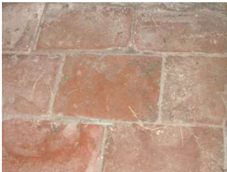
Slika 60. Pod lađe popločan rimskim ciglama u sekundarnoj upotrebi, kapela sv. Petra i Pavla u Boku Palanječkom, Župa sv. Kvirina, Sisak, snimila Z. Jembrih 2013.
