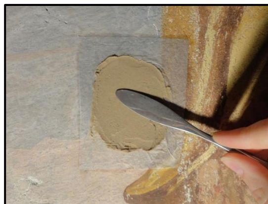
Slika 6. Nanošenje 10%-tnog amonijevog karbonata pomješanog sa sepiolitom preko japan papira
