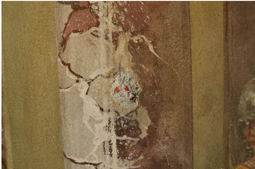
Slika 17. Žbukanje grubljom žbukom, drugi sloj
